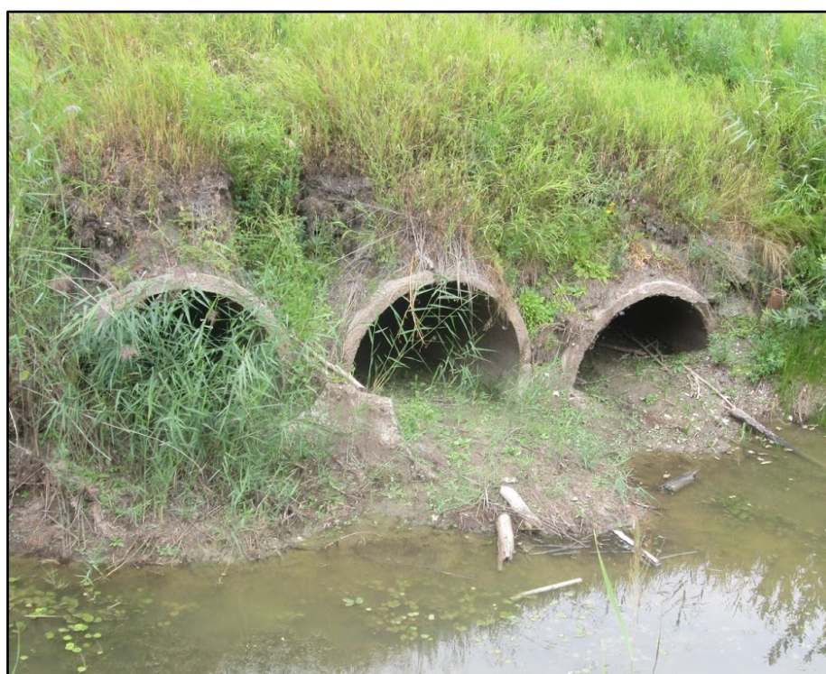
Рисунок 3 – Трубчатый переезд, подлежащий реконструкции.
