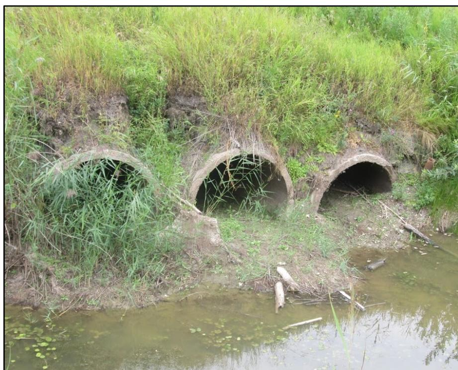
Рисунок 3 – Трубчатый переезд, подлежащий реконструкции.
